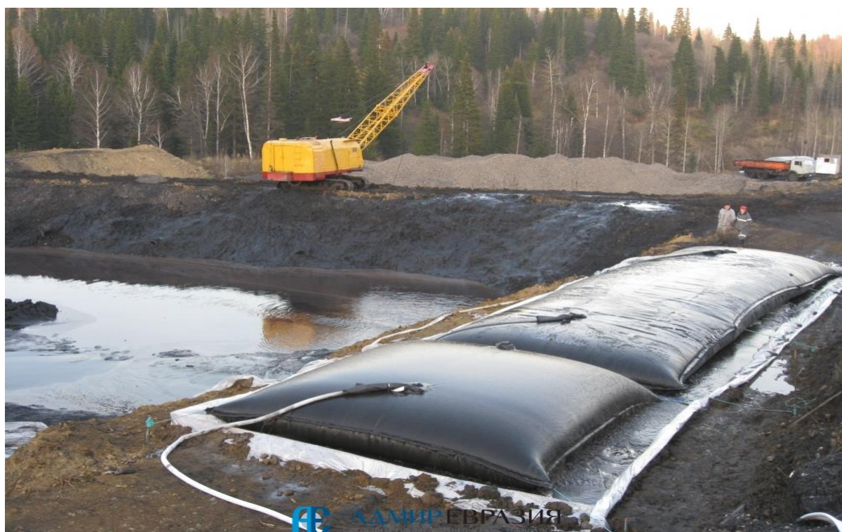
Рис. 3. Наполнение контейнера геотуб осадком карьерных вод [2]
